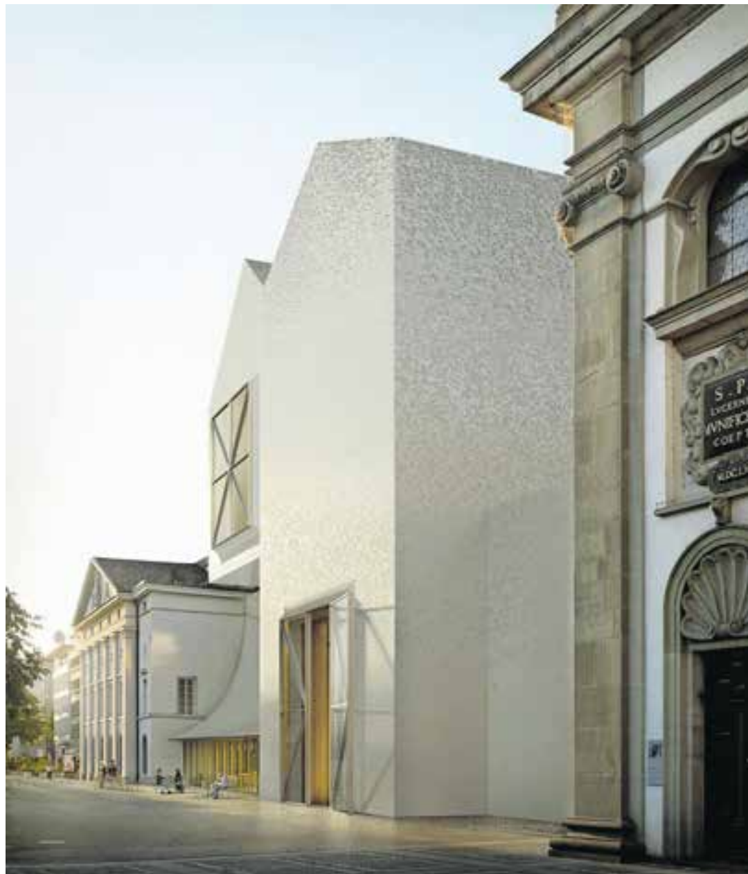
So stellen sich die Architekten Ilg und Santer das neue Luzerner Theater vor.
